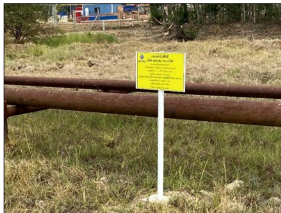
ภาพที่ 2.3-6 ป้ายเตือนสะท้อนแสงแสดงตำแหน่งแนววางท่อ
