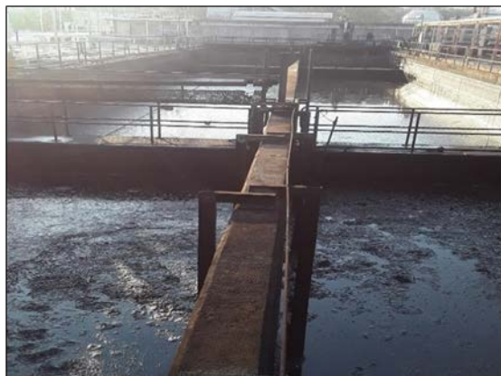
ภาพที่ 2.3-2 API Separator ที่สถานีผลิตลานกระบือ
