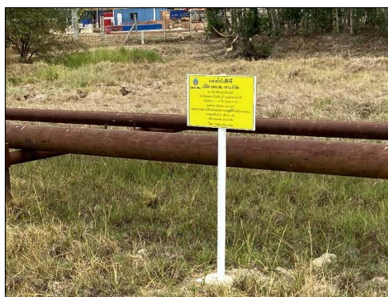
ภาพที่ 2.2-3 ป้ายเตือนสะท้อนแสงแสดงตำแหน่งแนววางท่อ
